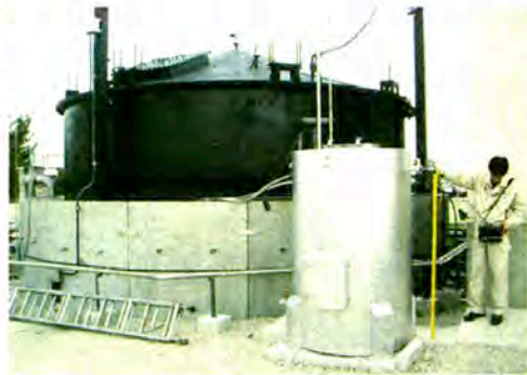
▲写真1 企業（佐賀県鳥栖市）所有の小型メタン発酵施設。牛ふんなどを毎日500kg投入し、約200kgのメタンガス（住宅約70軒分）を発電
